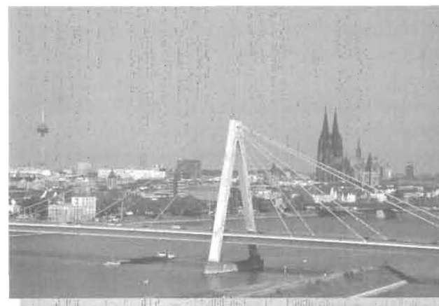
Für den Aufbruch in den 50-er Jahren steht die Severinsbrücke, die zum zweiten Wahrzeichen Kölns wurde.
